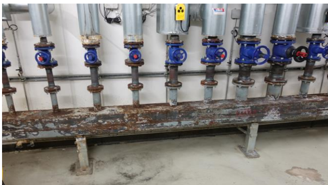
Korrosion nach Abpumpen
